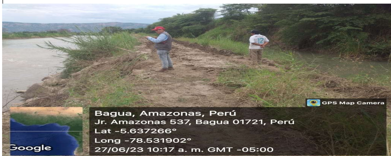
FIGURA N°03: PARTE DEL TRAMO SE ENCUENTRA COLMATADO Y CON UN TALUD DESPRENDIDO PONIENDO EN RIESGO AL CANAL LIMONYACO BAJO
