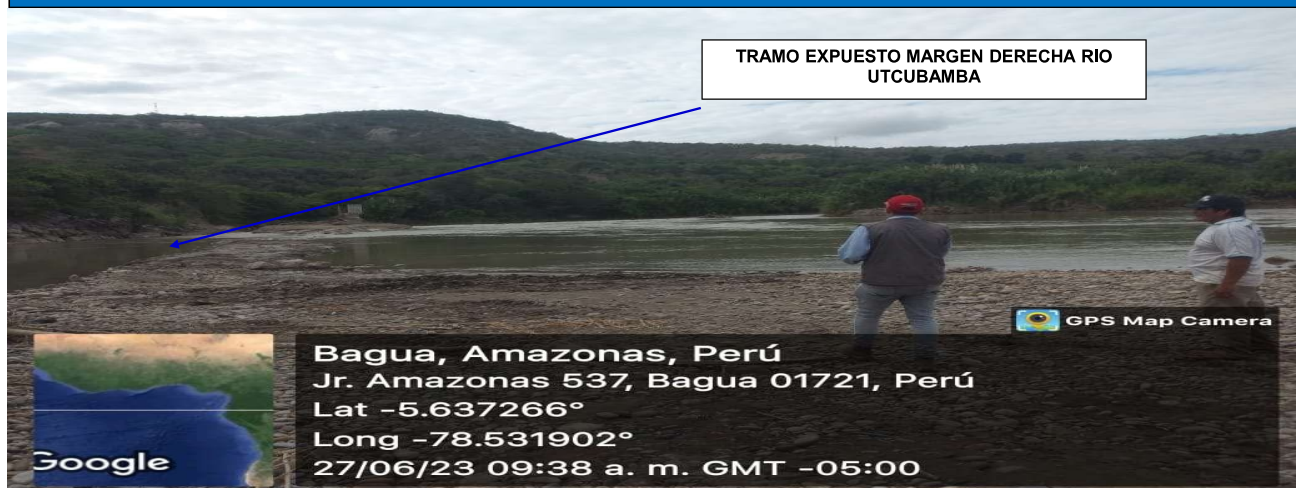
FIGURA N°01: TRAMO CRÍTICO MARGEN DERECHA SE ENCUENTRA DESPROTEGIDA DONDE INICIA EL CANAL LIMONYACO BAJO Y EN LA MÁRGEN IZQUIERDA AFECTA ZONA AGRICOLA.
